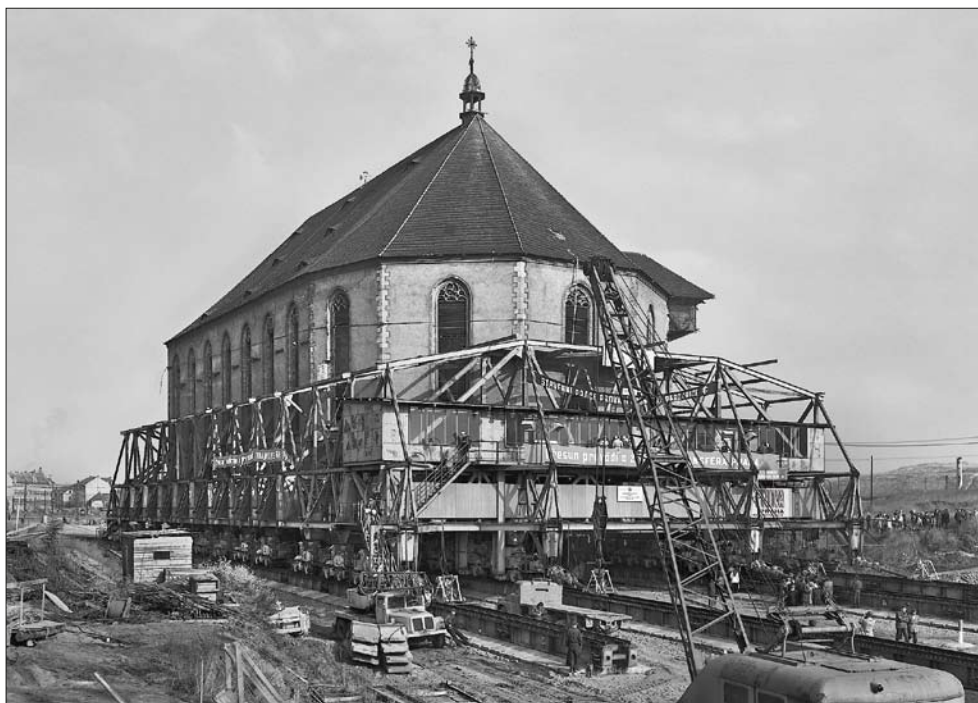
Fotosbírka NPÚ – kostel Nanebevzetí Panny Marie v Mostě během přesunu v roce 1975. Foto Čestmír Šíla.
